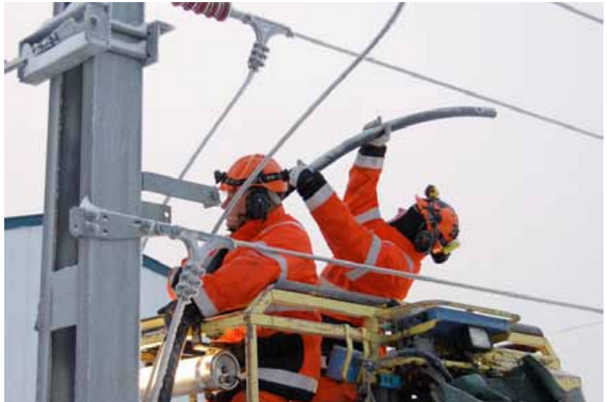
Järnvägens kontaktledningarna är oisolerade och ett exempel på där skyddet bygger på att ingen kan nå dem.
