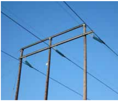
Kraftledningarna har ofta tre ledare som ibland dubblas till 6. På vissa sträckor finns även en extra jordledare.
